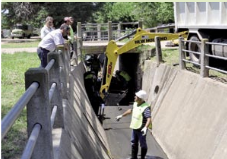
Las cooperativas locales trabajaron en la remoción de escombros
